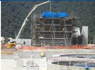
Final pour on SAG mill foundations
